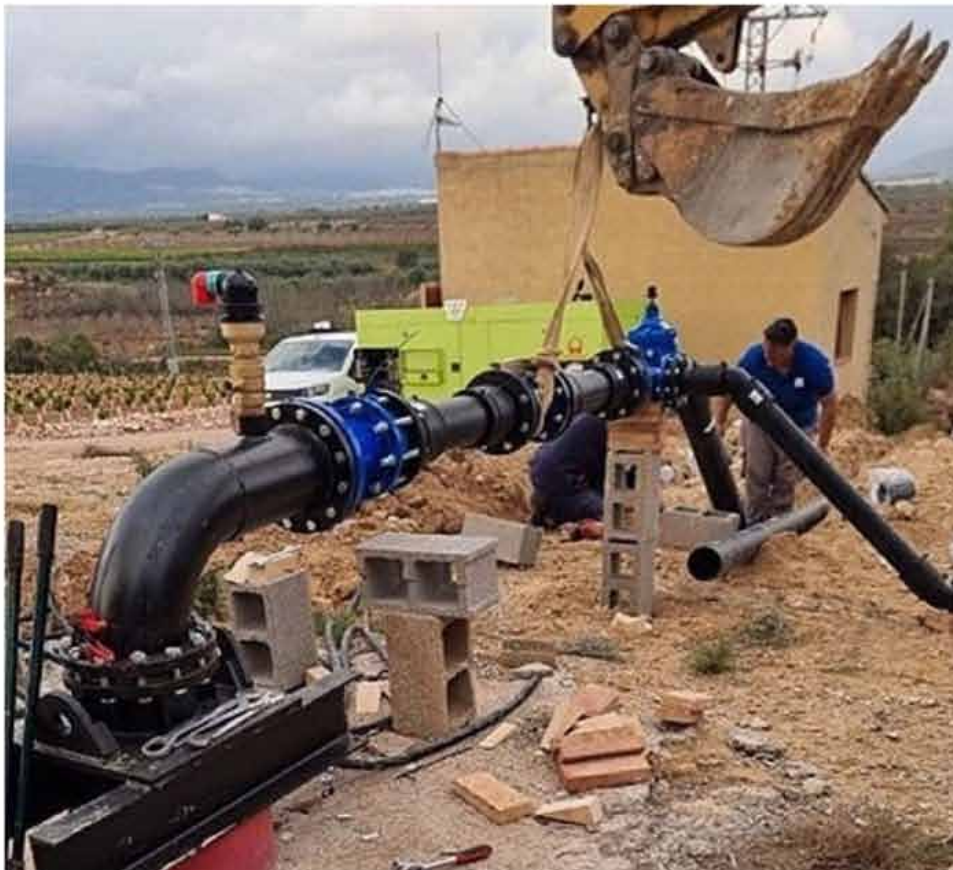
Egevasa equipa y pone en funcionamiento un pozo para abastecer a la población
